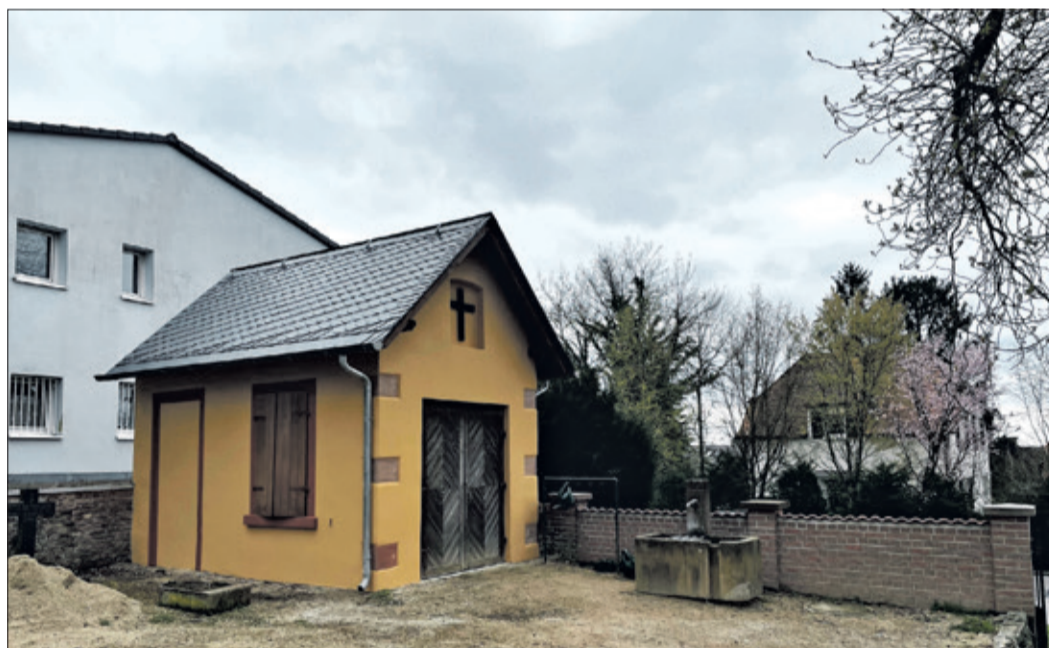
Die Grundsanierung der Schönberger Friedhofskapelle ist abgeschlossen. Die Holzarbeiten im Innenraum stehen noch aus.
