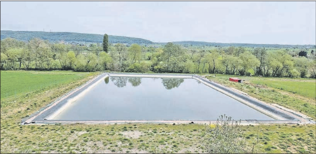
Landwirt Reiner Paul sammelt im Winter in seinem Reservoir das Wasser, sodass es in der trockenen Jahreszeit für die Bewässerung zur Verfügung steht. Foto: HTK
