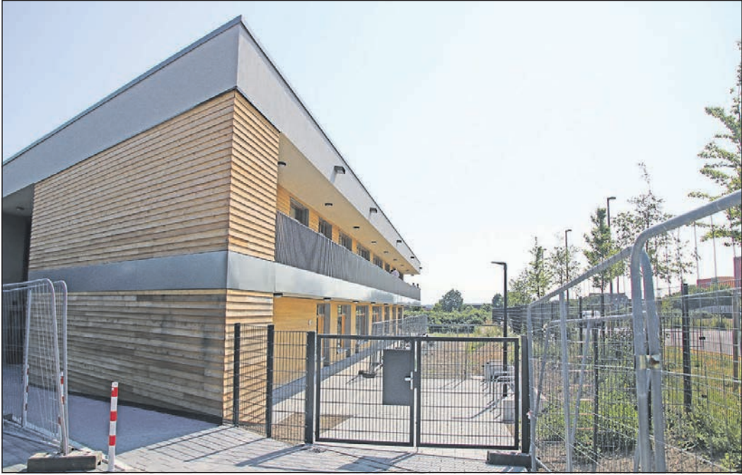
Die neue Kindertagesstätte in Dornholzhausen ist aus 400 Kubikmetern Fichtenholz gebaut worden. Foto: Ehmler
