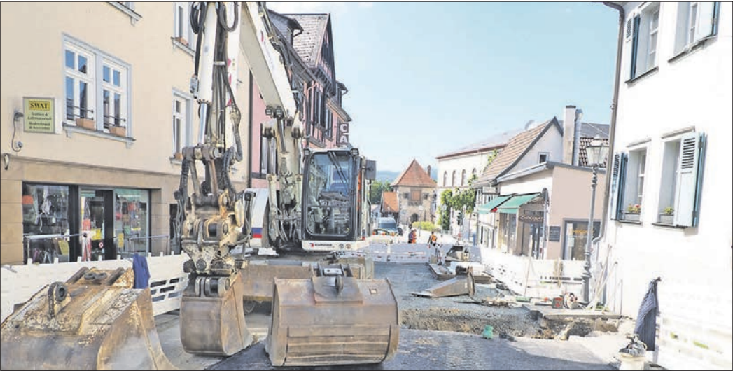
Für den Verkehr sind die Straßen während der Tiefbauarbeiten wie hier am Schulberg gesperrt.
