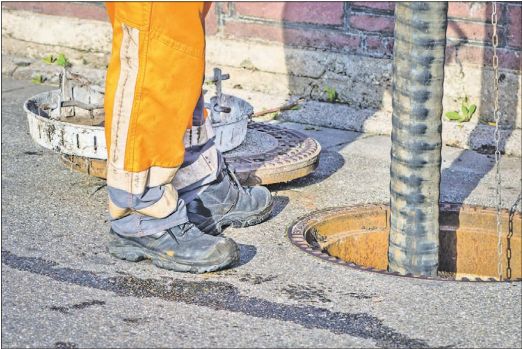
Voraussichtlich bis zum 8. September werden Kanalinspektionen im zukünftigen Streckenverlauf der U2, hauptsächlich entlang der Frankfurter Landstraße, durchgeführt. Foto: SBHG
