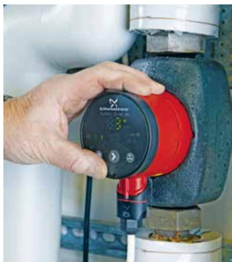
Wer seine alte Heizungspumpe durch eine moderne Hocheffizienzpumpe ersetzt, kann doppelt profitieren: von reduzierten Energiekosten durch geringeren Stromverbrauch der neuen Pumpe sowie einen hydraulischen Abgleich, der den Heizverbrauch optimiert. (Foto: epr/Grundfos)
