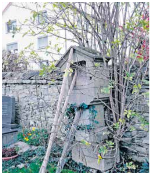
Das Wucherer-Grab ist in einem baufälligen Zustand. Foto: Privat
