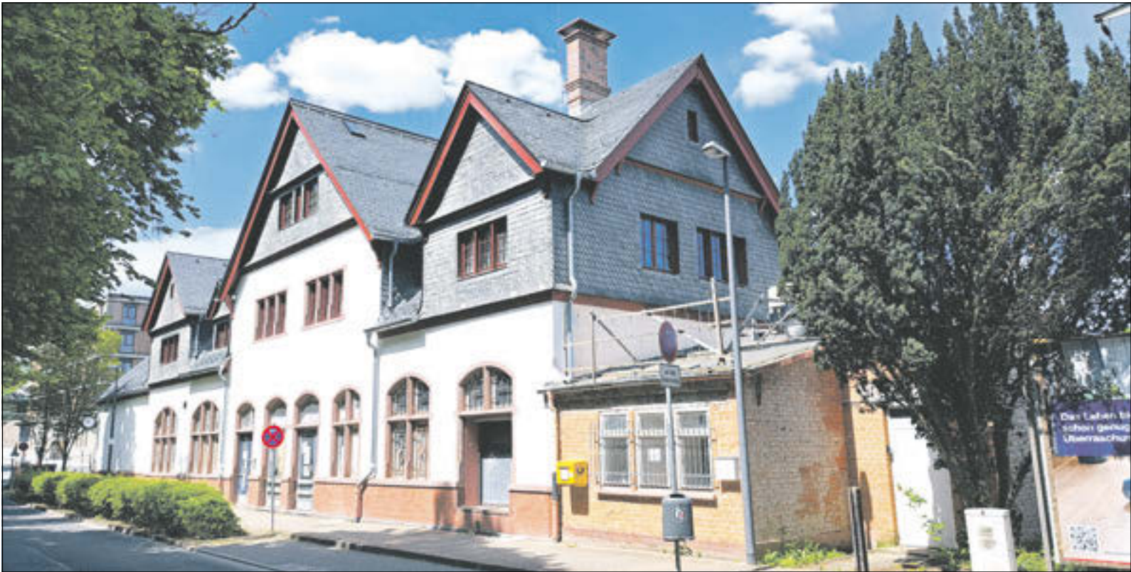
Die Baufortschritte am Kronberger Bahnhofsgelände werden mit großem Interesse verfolgt. Jetzt könnte ein bislang ungeklärter Wassereintritt im Kellerbereich für einen Baustopp sorgen. Fotos: Muth-Ziebe
