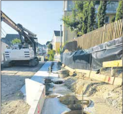
Die Arbeiten in der Hainstraße liegen im Zeitplan. Foto: Stadt Kronberg Kronberg (kb) – Im Zuge der Erneuerung der Stützmauer Hainstraße durch Hessen Mobil ist das erforderliche Großdrehbohrgerät
