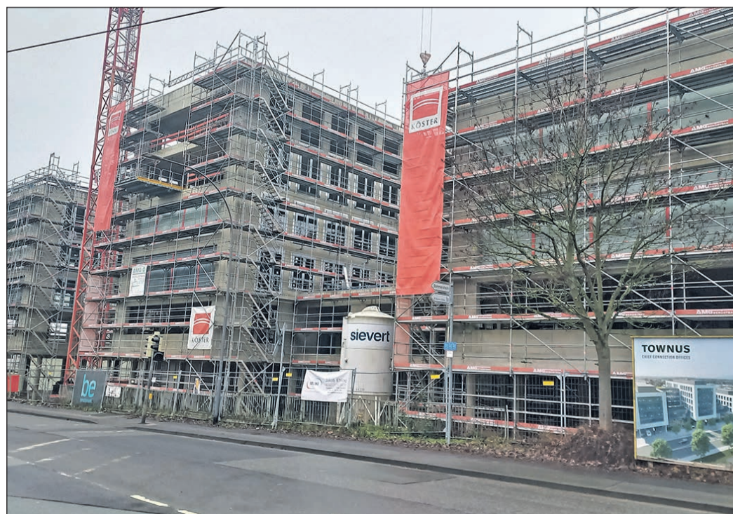
Seit der Grundsteinlegung im Frühsommer vergangenen Jahres geht es rasend schnell voran mit dem Hochbau. In knapp neun Monaten sind die drei „Townus“-Gebäude hochgezogen worden. Foto: js
