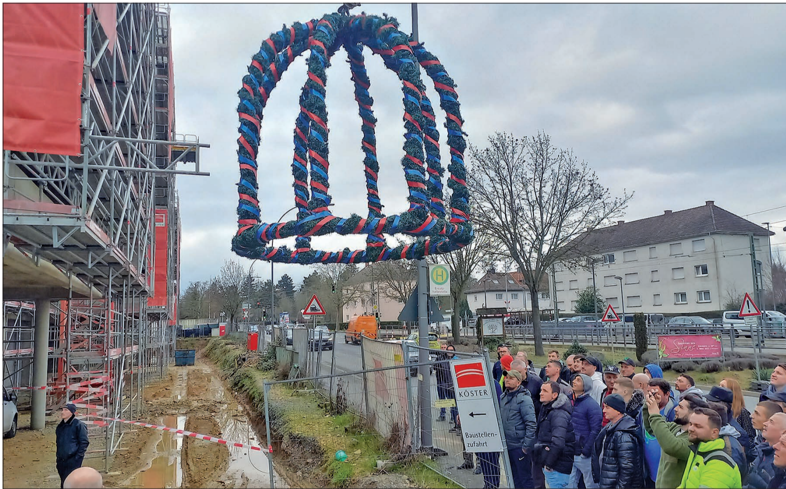
Nur ein Bruchteil der Gäste kann das Aufziehen des Richtkranzes und das kurze Ritual mit Polier und Richtspruch auf dem Gerüst live mitverfolgen. Und jene stehen schon fast auf der Straße, denn vor der Gebäudefront ist es reichlich eng. Foto: js
