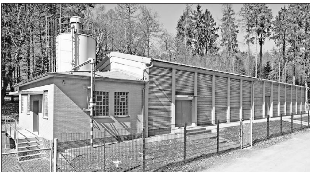
Die Turbine zur Stromgewinnung wird im Lauf dieses Jahres in der Wasseranlage Hohemark installiert. Foto: Stadtwerke Oberursel
