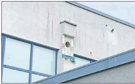
Im Zuge der Sanierungsvorbereitungen werden auch an der EKS-Sporthalle unzulässige Bohrungen entdeckt. Foto: Kreis
