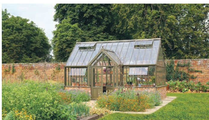
Die Struktur der Gewächshäuser ist klar, geordnet, praktisch und vor allem von langer Lebensdauer, Wind und Wetter können den Häusern über Jahrzehnte nichts anhaben.
