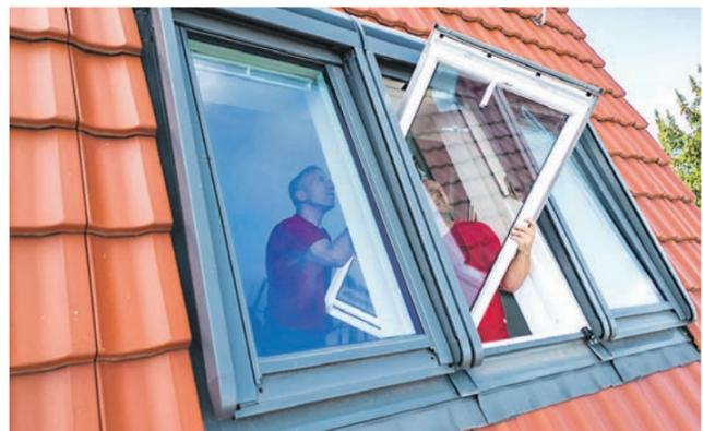
Wird ein Dachfenster eins zu eins ausgetauscht, geht dies binnen weniger Stunden über die Bühne, weil kein großer Eingriff in die Dachstruktur nötig ist.
