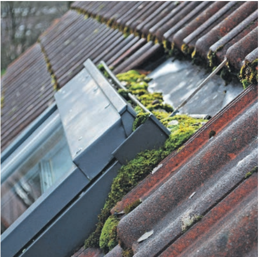
Moos und Laub können die Wasserabläufe rund ums Dachfenster verstopfen, sodass Regenwasser nicht mehr richtig abläuft. Es sucht sich dann seinen Weg ins Innere, was nicht nur unschöne Flecken an der Wand zur Folge haben kann. Schlimmstenfalls weicht die Dämmung auf, es droht ein erheblicher Schaden an der Bausubstanz. Foto: DJD/TLS-Dachfenster
