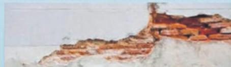
Wenn der alte Putz reißt oder bröckelt sollte der Hausbesitzer nicht lange mit einer Sanierung warten! Risse und Löcher in der Fassade sind nicht nur unschön, sie können langfristig schwere Schäden zur Folge haben weil der Außenputz das Mauerwerk nicht mehr ausreichend von Feuchtigkeit und Umwelteinflüssen schützen kann. Aber keine Sorge, um höhere Kosten zu vermeiden lohnt es sich einen Experten von uns zu rufen und den Schaden langfristig zu beheben.
