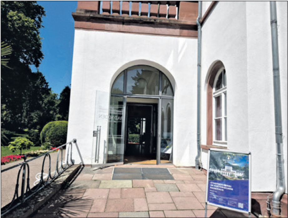
Die beiden Eingänge ins Badehaus sind nach der Sanierung jetzt wieder begehbar. Foto: Stadt Bad Soden
