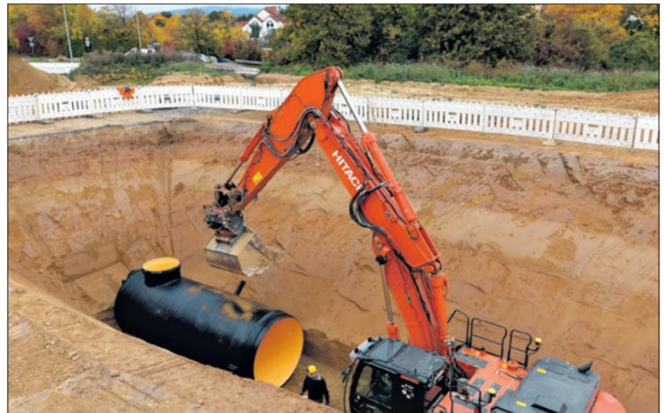
Derzeit werden die Rohre des Stauraumkanals mit einem Durchmesser von zwei Metern verlegt. Foto: Stadt Bad Soden
