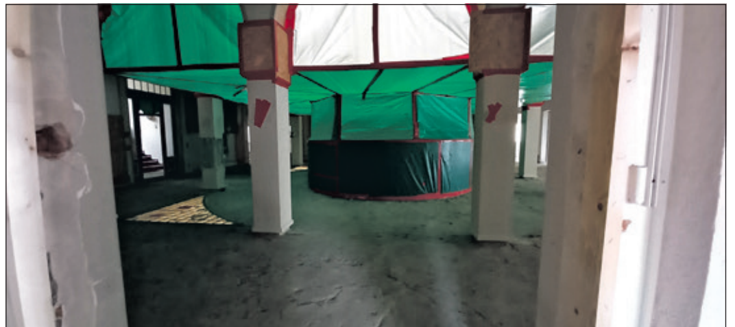
Die Schadstoffsanierung im zweiten Obergeschoss ist fast abgeschlossen. Foto: Stadt Bad Soden
