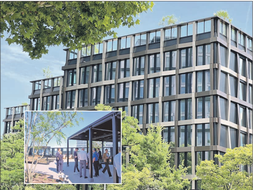
Im rund 1.000 Quadratmeter großen Dachgarten im siebten Stock stellte „Wöhr + Bauer“ eines der modernsten Bürogebäude Eschborns vor. Fotos: Wöhr + Bauer/Schlosser
