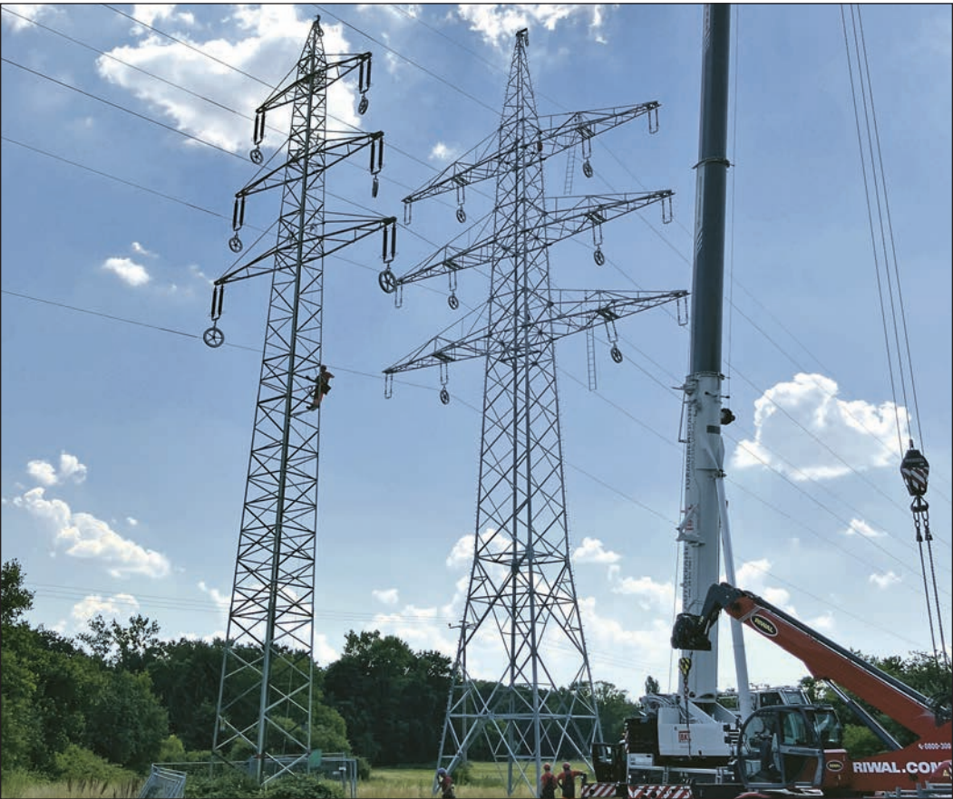
Noch stehen zwei Masten nebeneinander, doch der neue Mast (rechts) führt bereits das weiter genutzte Leiterseil, während der alte Mast (links) demontiert wird. Foto: Syna
