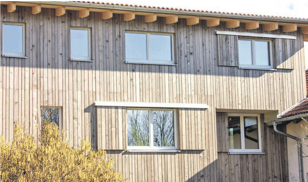
Die thermische Behandlung macht heimisches Holz zu einem witterungsbeständigen und pflegeleichten Material, das sich sehr gut für Fassaden eignet. Foto: DJD/Swero
