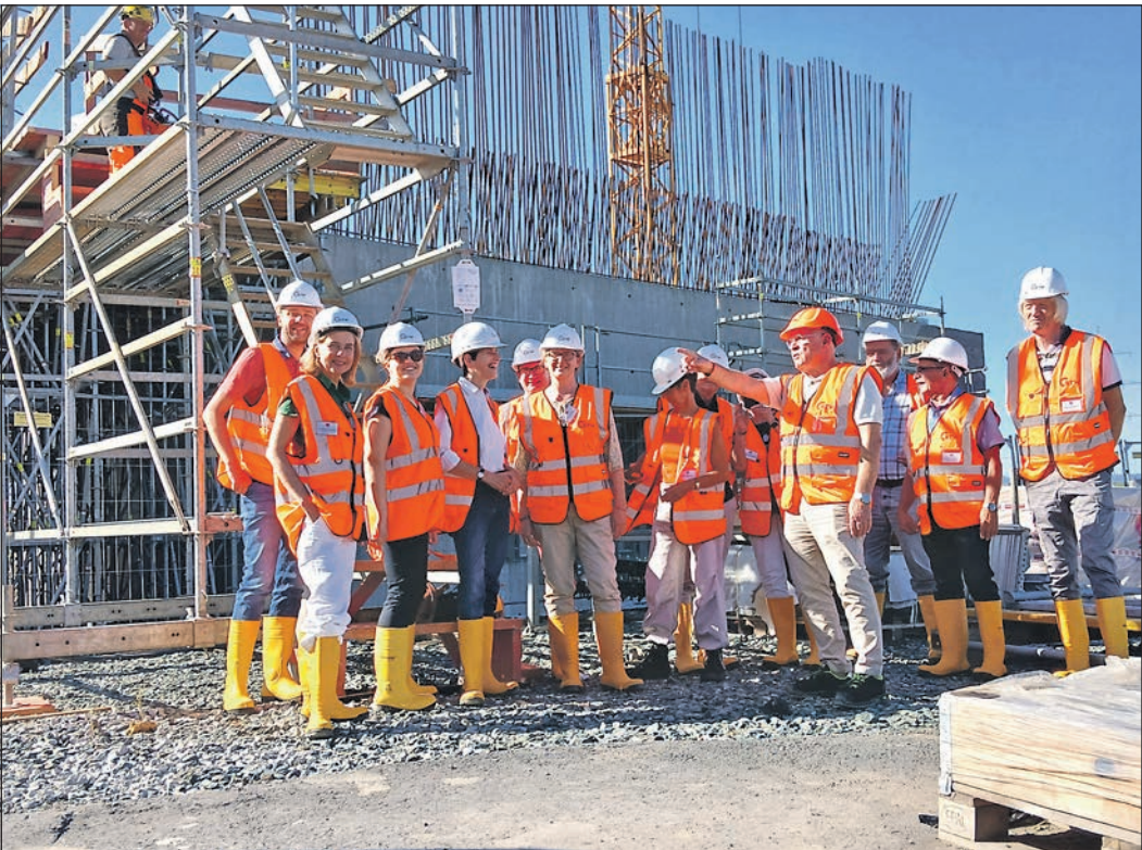
RTW-Geschäftsführer Horst Amann (oranger Helm) erläuterte den SPD-Kommunalpolitikerinnen und -politikern die Baustelle in der Eschborner Feldgemarkung. Foto: Schlosser
