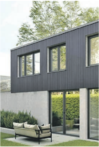
Wer sein Haus renoviert, sollte nicht bei der Heizung anfangen, sondern mit der Gebäudehülle.
