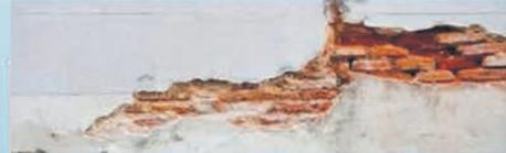
Wenn der alte Putz reißt oder bröckelt sollte der Hausbesitzer nicht lange mit einer Sanierung warten! Risse und Löcher in der Fassade sind nicht nur unschön, sie können langfristig schwere Schäden zur Folge haben weil der Außenputz das Mauerwerk nicht mehr ausreichend von Feuchtigkeit und Umwelteinflüssen schützen kann. Aber keine Sorge, um höhere Kosten zu vermeiden lohnt es sich einen Experten von uns zu rufen und den Schaden langfristig zu beheben.
