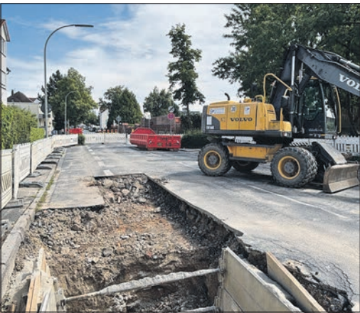
Die Bauarbeiten wegen des Wasserrohrbruchs im Gluckensteinweg dauern voraussichtlich bis September. Foto: Stadt
