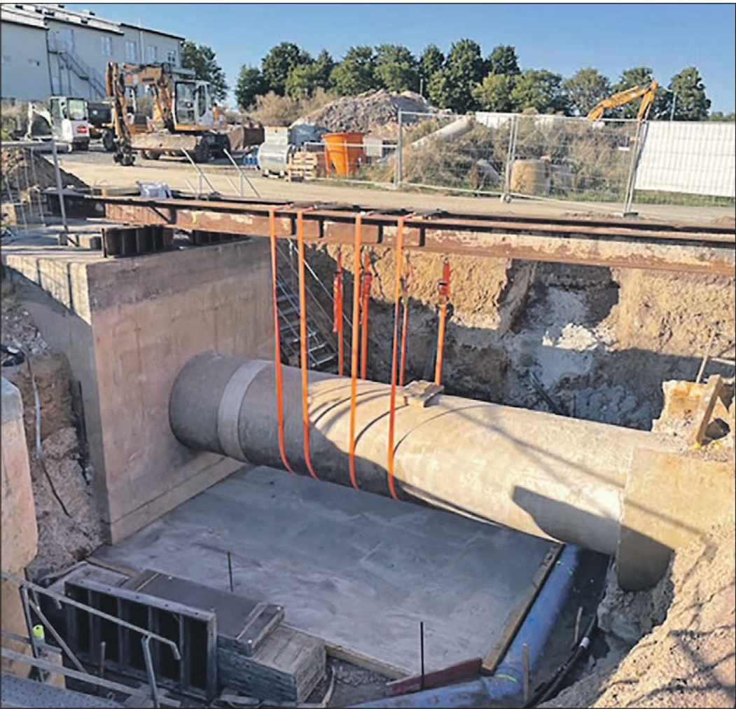
Die Ferienfraktion der SPD hat sich bei einem Besuch des Klärwerks umfassend über den Betrieb informiert. Foto: SPD-Fraktion
