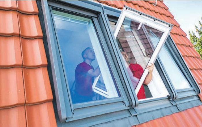
Wird ein Dachfenster eins zu eins ausgetauscht, geht dies binnen weniger Stunden über die Bühne, weil kein großer Eingriff in die Dachstruktur nötig ist. Foto: DJD/TLS-Dachfenster
