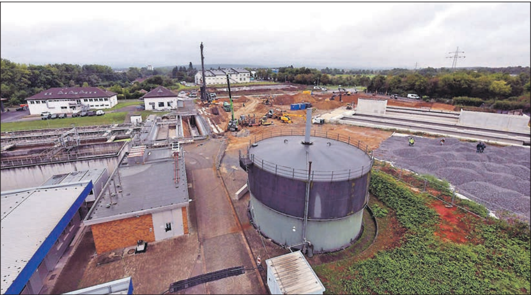
Ein Blick über das Kläranlagen-Areal zeigt den Stand der Bauarbeiten. Foto: Reichwein
