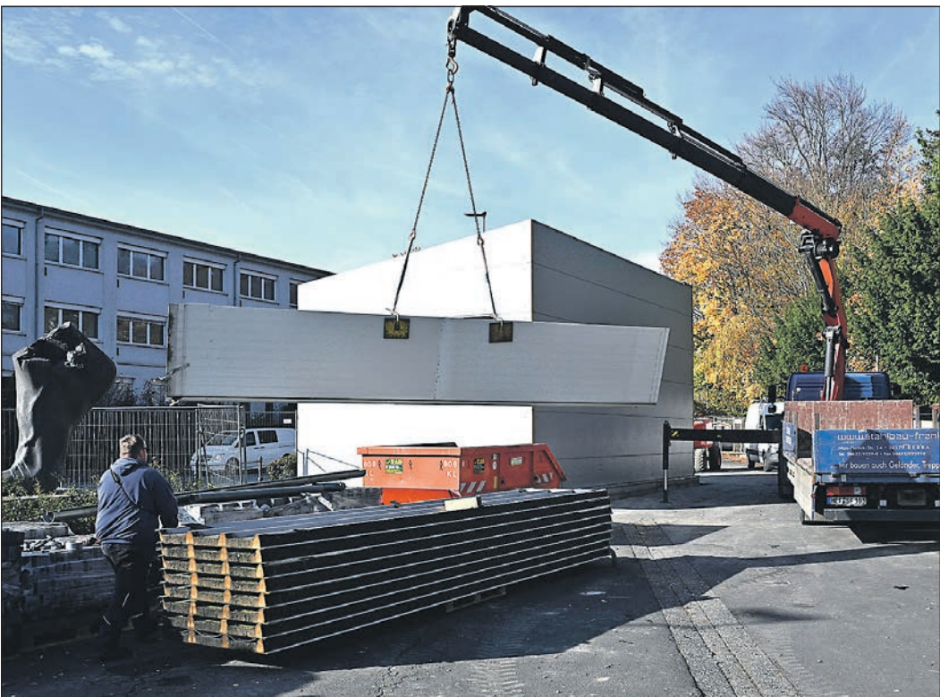
Stück für Stück wird die Feuerwehr-Behelfshalle in Dornholzhausen abgebaut. Foto: fk
