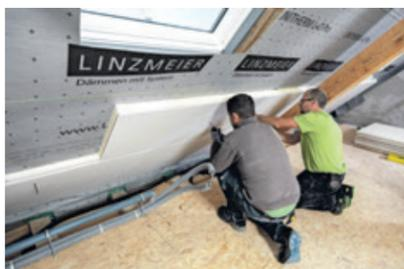
Die Untersparrendämmung UNITHERM PAL GK ist nicht nur schnell und einfach anzubringen: Dank aufkaschierter Gipskartonplatte lassen sich die Wände anschließend individuell gestalten.
