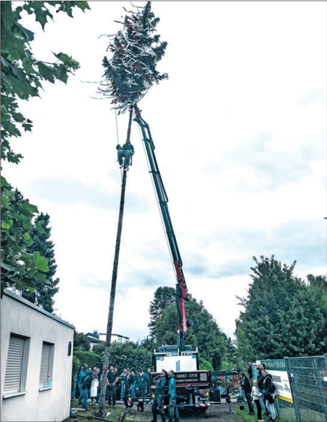
Präzisionsarbeit: Um den Kerbebaum senkrecht in die betonierte Bodenhülse zu bekommen, war bei den beengten Verhältnissen am Kerbeplatz neben Augenmaß auch ein professioneller Ladekran vonnöten.
