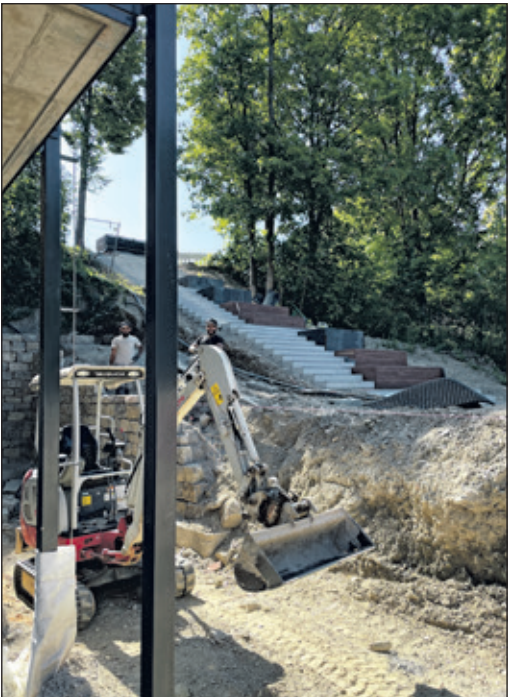
Diese Treppe führt aus dem hinteren Teil der Höfe nach oben in die Sodener Straße.
