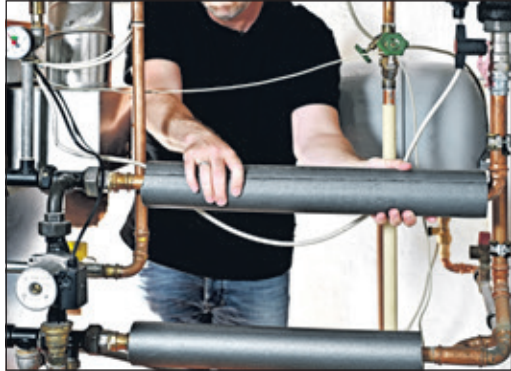
Rohre dämmen Foto: HLMU
