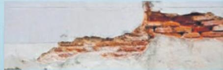
Wenn der alte Putz reißt oder bröckelt sollte der Hausbesitzer nicht lange mit einer Sanierung warten! Risse und Löcher in der Fassade sind nicht nur unschön, sie können langfristig schwere Schäden zur Folge haben weil der Außenputz das Mauerwerk nicht mehr ausreichend von Feuchtigkeit und Umwelteinflüssen schützen kann. Aber keine Sorge, um höhere Kosten zu vermeiden lohnt es sich einen Experten von uns zu rufen und den Schaden langfristig zu beheben.
