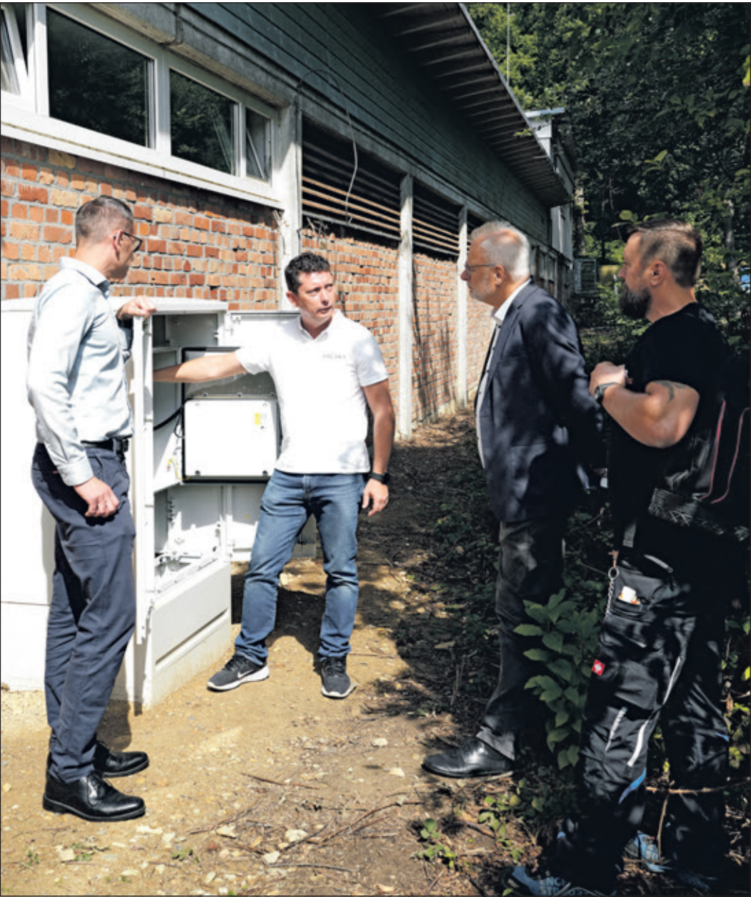
Sebastian Fischer, Geschäftsführer des gleichnamigen Sirenenbau-Unternehmens (2.v.l.) erklärt Bürgermeister Christoph König (2.v.r.) und Daniel Höber (l.), Leiter des städtischen Fachreferats Bevölkerungsschutz, am Schaltschrank die Funktionsweise der neuen Sirene am Waldschwimmbad.
