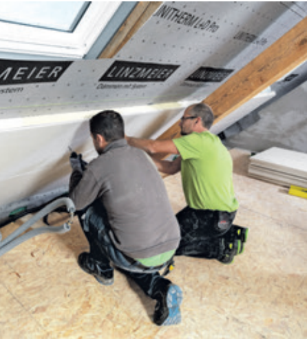
Die Untersparrendämmung LINITHERM PAL GK ist nicht nur schnell und einfach anzubringen: Dank aufkaschierter Gipskartonplatte lassen sich die Wände anschließend individuell gestalten.
