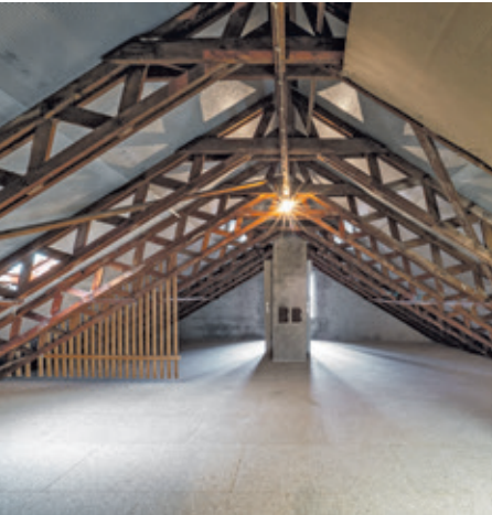
Für einen weiterhin begehbaren und belastbaren Dachboden kommt LINITHERM PAL PHW in Frage. Das System schützt die darunterliegenden Räume zuverlässig vor Wärmeverlust, während der Dachboden weiterhin als Stauraum genutzt werden kann.
