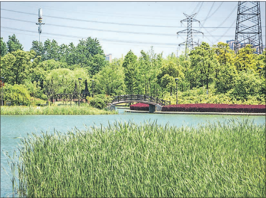
Der Ausbau des Hochspannungsnetzes soll gemeinsam angegangen werden. Foto: Freepik
