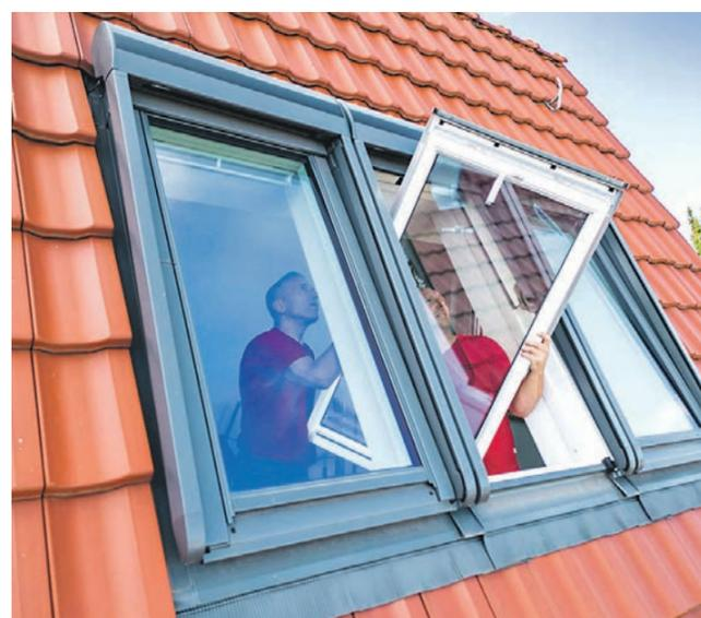
Wird ein Dachfenster eins zu eins ausgetauscht, geht dies binnen weniger Stunden über die Bühne, weil kein großer Eingriff in die Dachstruktur nötig ist. Foto: DJD/TLS-Dachfenster
