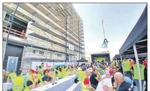
Direkt vor der Baustelle am Kronberger Hang feierten am vergangenen Donnerstag die Bauarbeiter und die Verantwortlichen der Firma „Maincubes“ das Richtfest des riesigen Rechenzentrums „FRA03“ auf dem ehemaligen Samsung-Gelände. Foto: Schlosser
