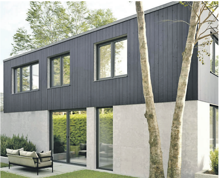
Renovieren und Sanieren bedeutet nicht nur, frisch zu streichen. Wer zukünftig Energie einsparen und ein angenehmes Wohnklima schaffen möchte, kümmert sich im ersten Schritt um eine gut gedämmte Hausfassade. Foto: DJD/REHAU
