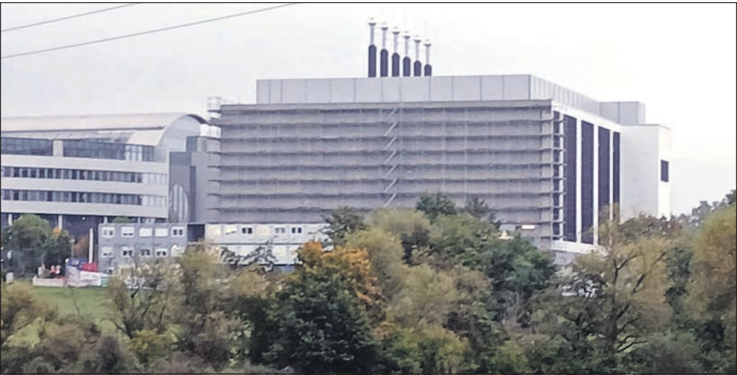
Auch die Abwärme des Rechenzentrums „FRA 03“, das gerade gebaut wird, soll in Zukunft die Wohnungen in der Limesstadt beheizen. Foto: Schlosser
