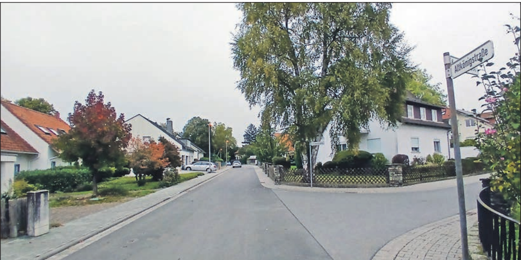
Die Sanierung der Altkönigsstraße, die im Frühjahr abgeschlossen wurde, hat rund 200.000 Euro mehr als geplant gekostet. Foto: Schlosser
