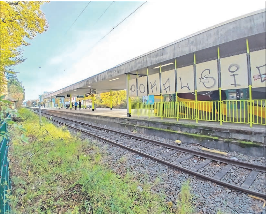
Auch am S-Bahn-Haltepunkt in Niederhöchstadt werden ab morgen fast zwei Wochen lang keine S-Bahnen vorbeikommen. Der RMV setzt Ersatzbusse ein. Foto: Schlosser
