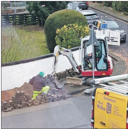
Zurzeit verlegen die Bautrupps die Glasfaserkabel in der Niederräder Straße in Alt-Schwalbach. Foto: Schlosser
