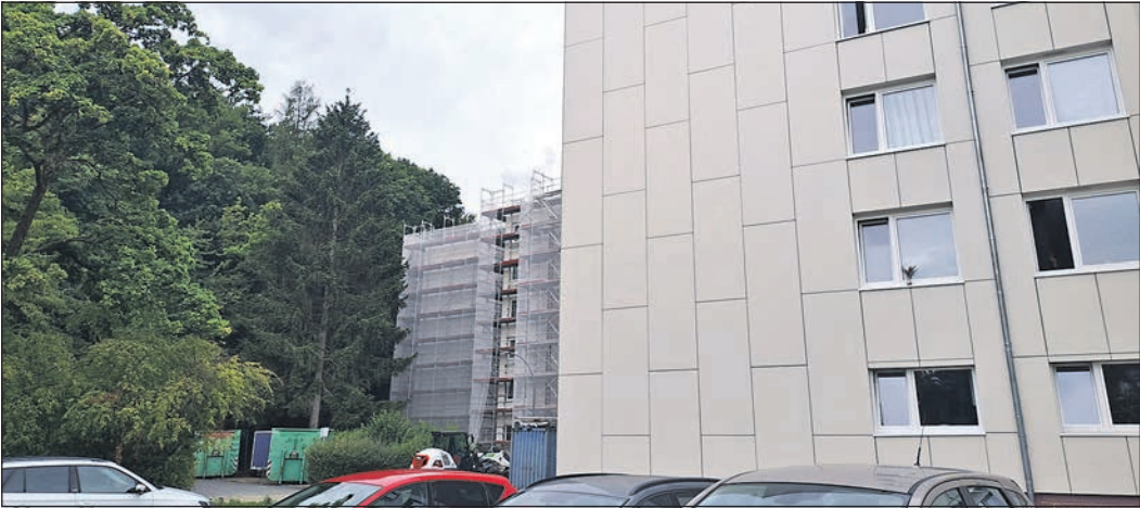
Bauvorhaben im Sankt-Hedwigs-Weg: Die Stellplätze vor dem Haus mit dem Gerüst wären betroffen. Foto: gt
