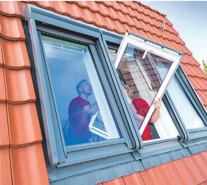
Wird ein Dachfenster eins zu eins ausgetauscht, geht dies binnen weniger Stunden über die Bühne, weil kein großer Eingriff in die Dachstruktur nötig ist. Foto: DJD/TLS-Dachfenster
