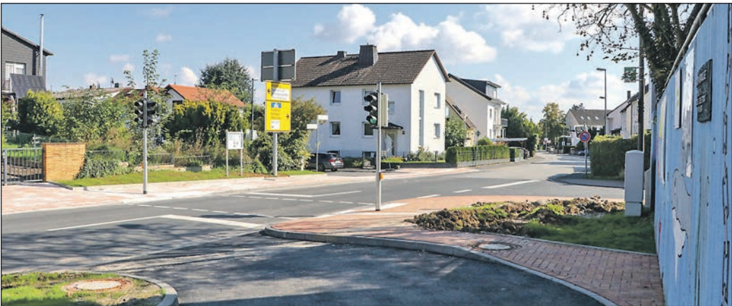
Im Bereich der Einmündung Sodener Straße sind noch einige Anpassungen für den Verkehr geplant. Foto: N. Gruber
