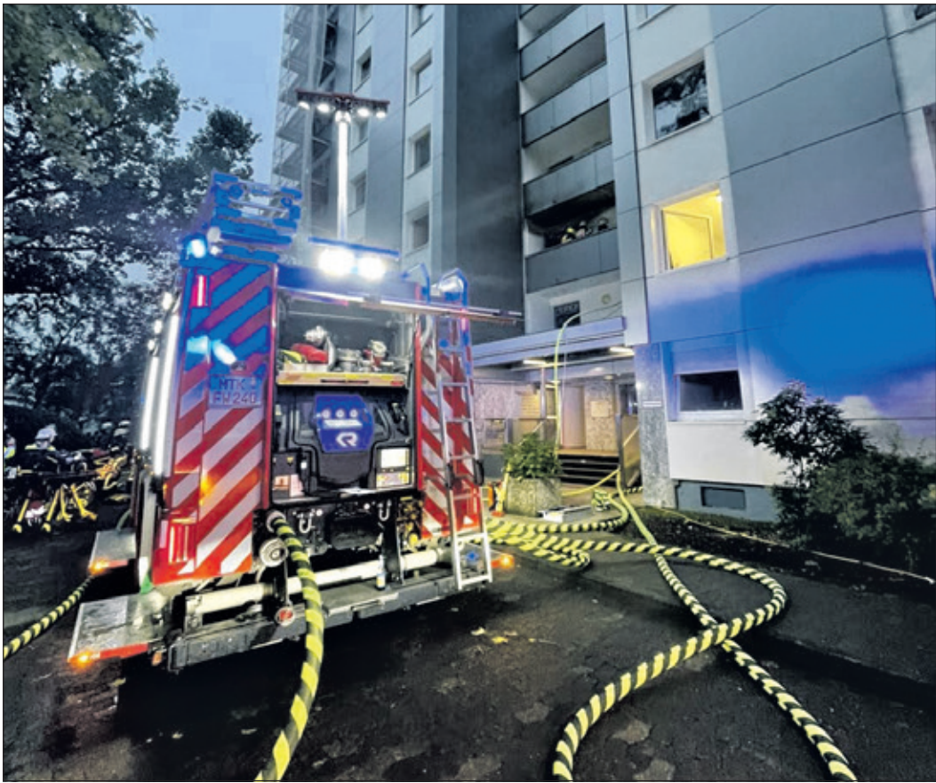
Ein Feuer in diesem Hochhaus in der Berliner Straße in Eschborn führte zu einem Großeinsatz von Feuerwehr, Technischem Hilfswerk und Rettungsdiensten. Foto: Feuerwehr Eschborn
