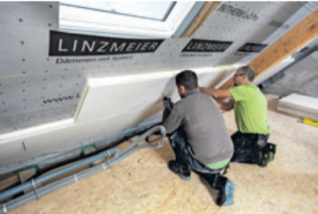
Die Untersparrendämmung UNITHERM PAL GK ist nicht nur schnell und einfach anzubringen: Dank aufkaschierter Gipskartonplatte lassen sich die Wände anschließend individuell gestalten. (Foto: epr/Linzmeier)
