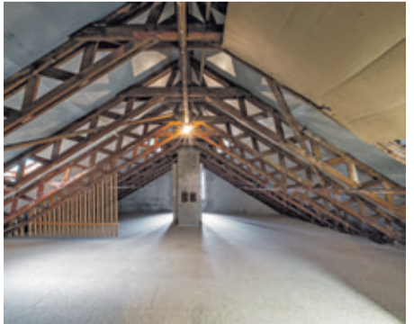
Für einen weiterhin begehbaren und belastbaren Dachboden kommt UNITHERM PAL PHW in Frage. Das System schützt die darunterliegenden Räume zuverlässig vor Wärmeverlust, während der Dachboden weiterhin als Stauraum genutzt werden kann. (Foto: epr/Linzmeier)
