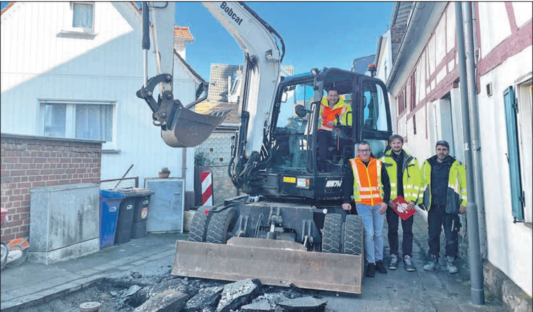
Die Bauarbeiten an der Bornstraße haben begonnen. Foto: Stadt
